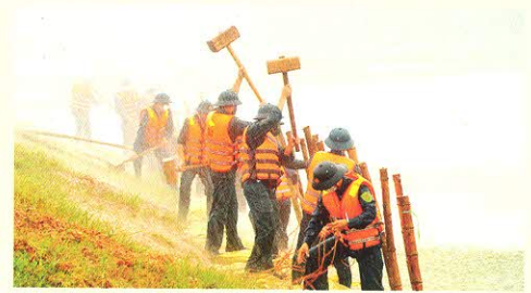
Cán bộ, chiến sĩ gia cố đê, chống sạt trượt tại buổi diễn tập
