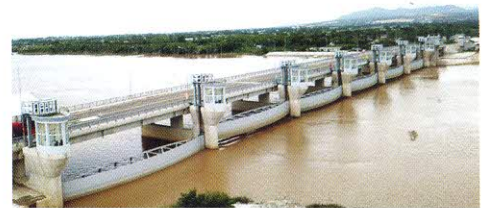
Công trình đập hạ lưu sông Dinh (Ninh Thuận) với hệ thống 6 cửa đập góp phần ngăn xâm nhập mặn vào mùa hạn và thoát lũ vào mùa mưa
