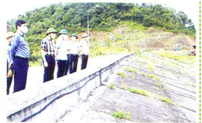
Đoàn kiểm tra đập chính hồ thủy điện Hương Sơn
