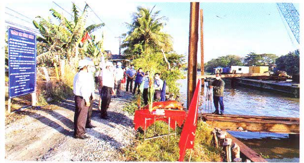
Khởi công đập thép ngăn mặn trên kênh Nguyễn Tấn Thành sáng 7/2
