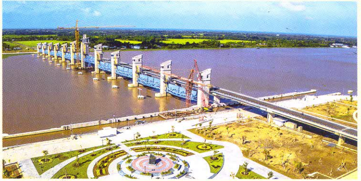
Cống Cải Lớn thuộc hệ thống thủy lợi Cải Lớn - Cải Bé
