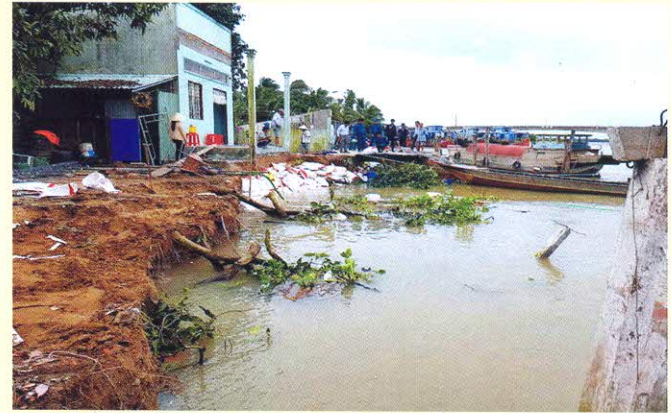
Vụ sạt lở bờ sông Cai Côn, xã Xuyên Hòa, huyện Kế Sách vào cuối tháng 6/2019
