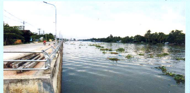
Bờ kè sông Ô Môn (quận Ô Môn, TP Cần Thơ) đã xây dựng hoàn thành, khắc phục sạt lở, ổn định bờ sông
