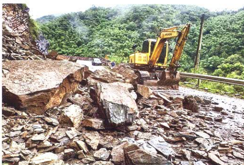
Mưa lớn gây Lở đá trên Quốc Lộ 37, đoạn dốc Cao Đa, thuộc địa phận xã Phiêng Ban, huyện Bắc Yên, tỉnh Sơn La gây ách tắc giao thông
