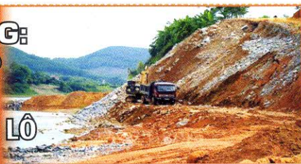
Đơn vị thi công đang khẩn trương thực hiện Dự án
