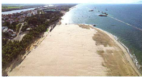
Dự án chống xói lở khẩn cấp bờ biển Cửa Đại triển khai vào tháng 7.2021 với kinh phí 300 tỷ đồng từ nguồn vốn Trung ương
