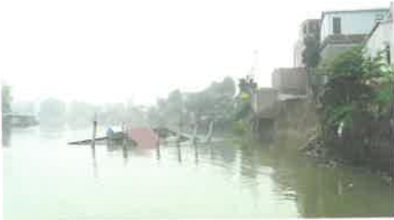
Ngôi nhà bị sạt lở xuống lòng sông Cầu phường Vạn An, TP Bắc Ninh
