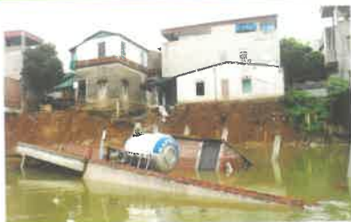
Sự cố sạt lở đề đã làm một ngôi nhà hai tầng trong khu vực trôi xuống sông.
