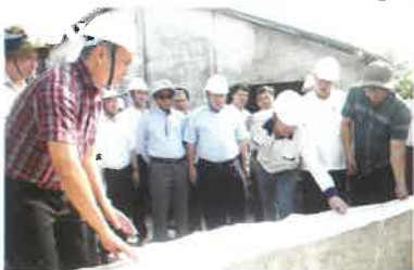
Tổ công tác liên ngành kiểm tra thực địa thi công dự án xử lý sạt lở bờ kênh Nàng Mau (tỉnh Hậu Giang)
